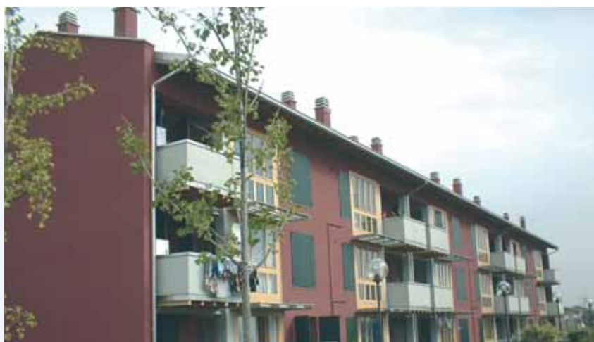
Verdellino intervento di bioedilizia
