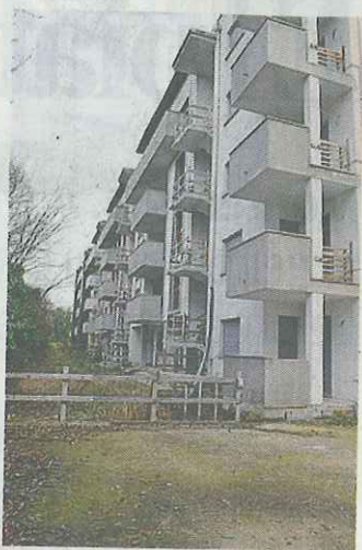
Il cantiere a Borgo Palazzo
