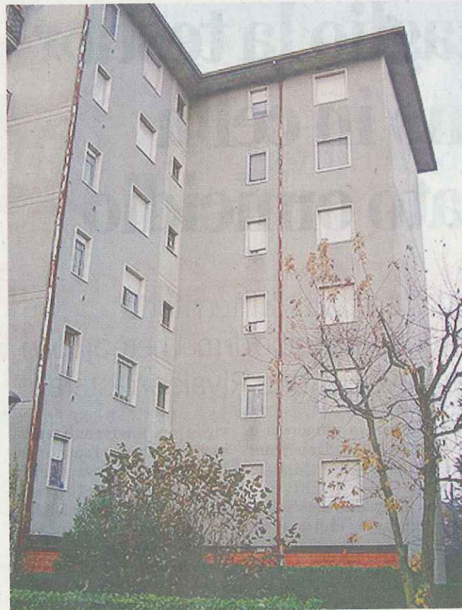
Il complesso residenziale in via Filzi a Treviglio
