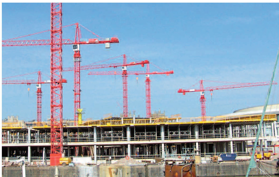
Immagine di un cantiere
