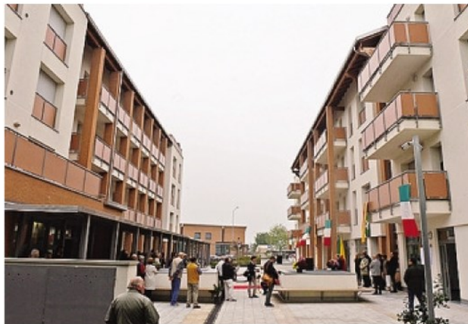
Le nuove case dell'Aler a Grumello del Piano FOTO BEDOLIS
