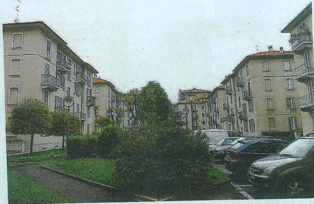
Lavori sono previsti anche alle case Aler di via IV Novembre
