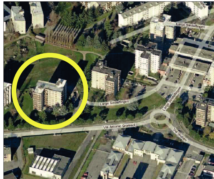
Parti comuni edificio
