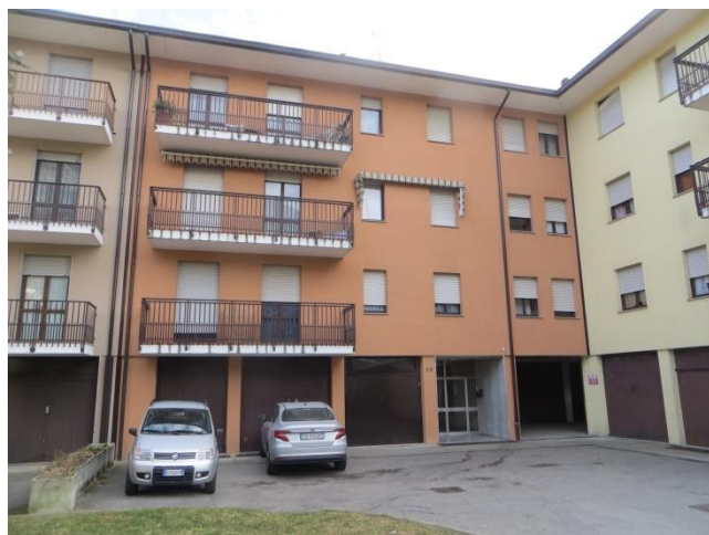
Fronte nord e est t
