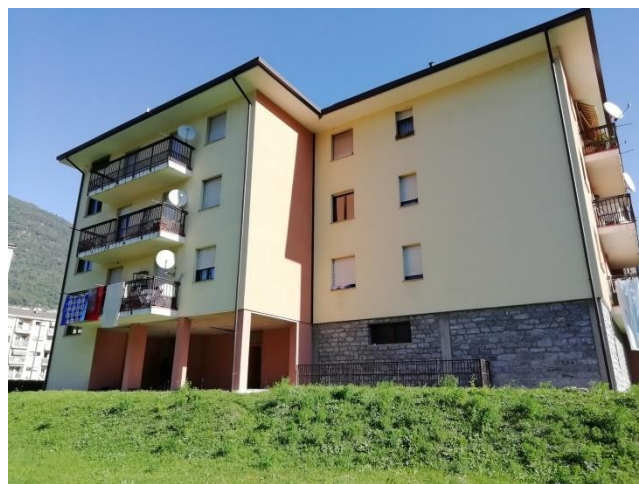
Fronte ovest e sud
