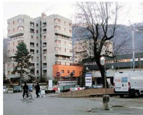
Sondrio, due delle tre torri alla Piastra interessate dall'intervento
