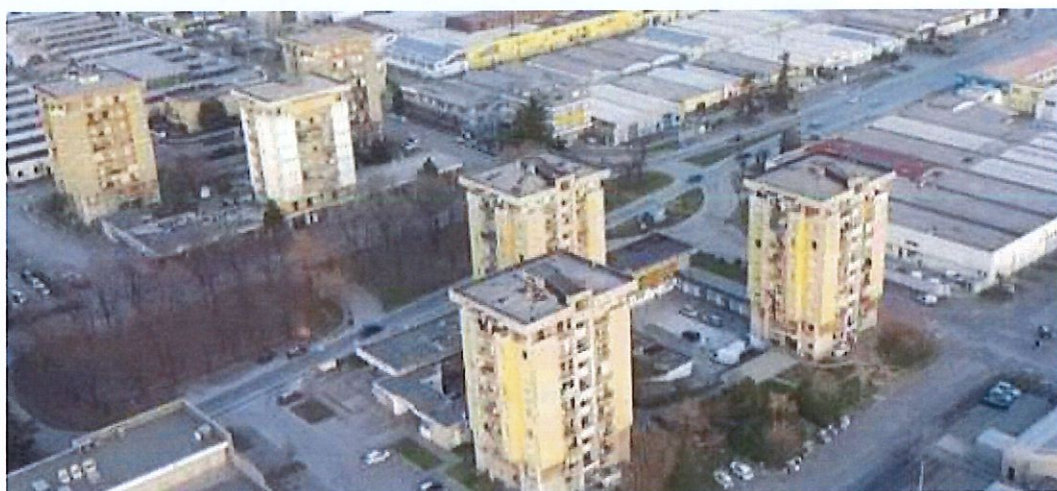
Le sei torri di Ciserano prima dell'abbattimento
