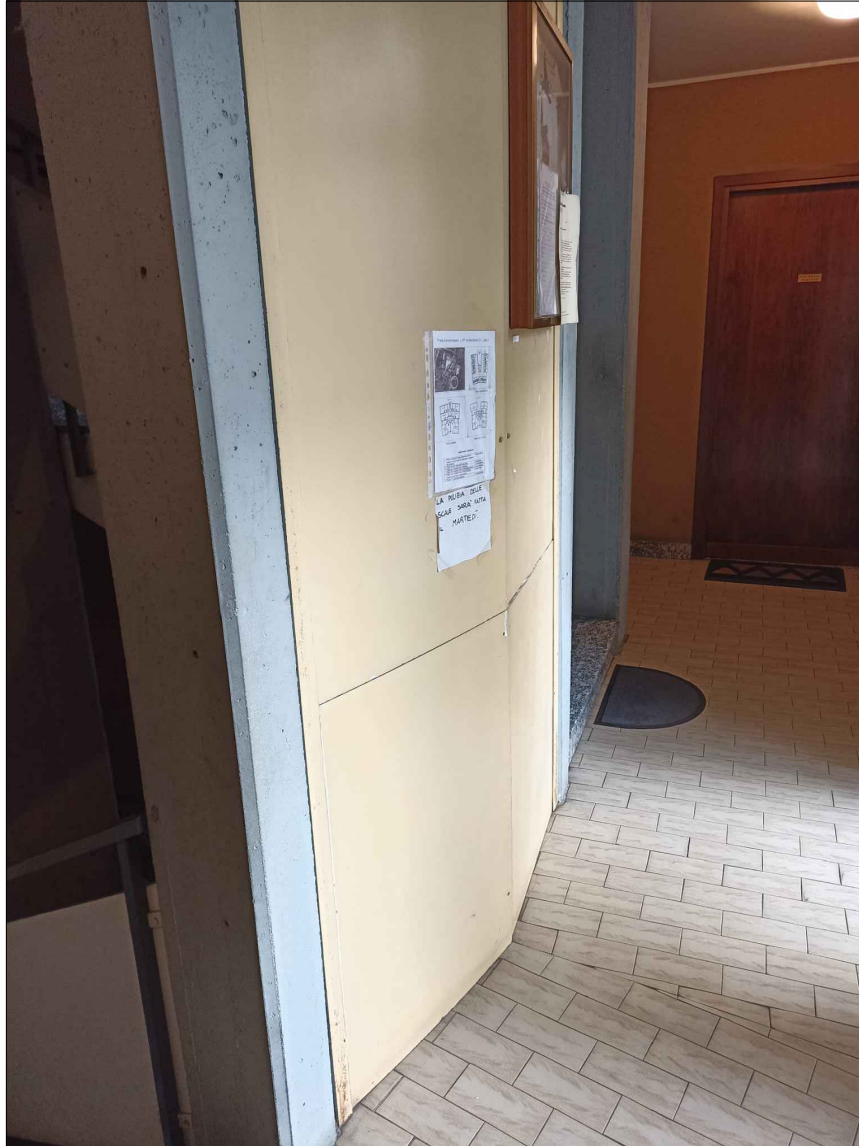
MANUFATTI IN AMIANTO VANO SCALA
