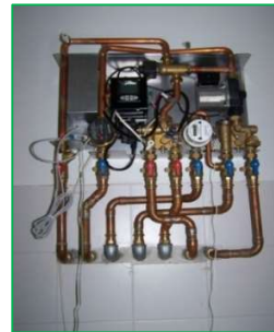
Unità satellitare: contabilizzazione del calore
