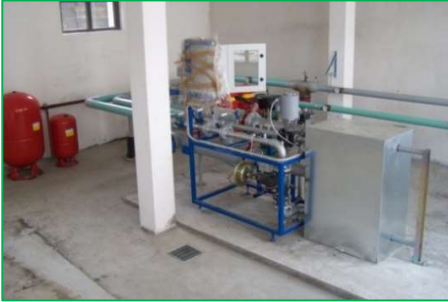
Stazione di teleriscaldamento
