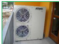
POMPA DI CALORE E IMPIANTO A TUTT'ARIA
