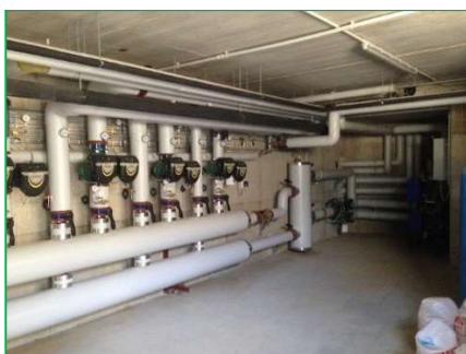
SOTTOSTAZIONE DEL TELERISCALDAMENTO E CENTRALE TERMICA
