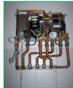
Unità satellitare: contabilizzazione del calore
