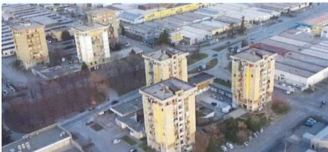
Le sei torri di Ciserano prima dell'abbattimento
