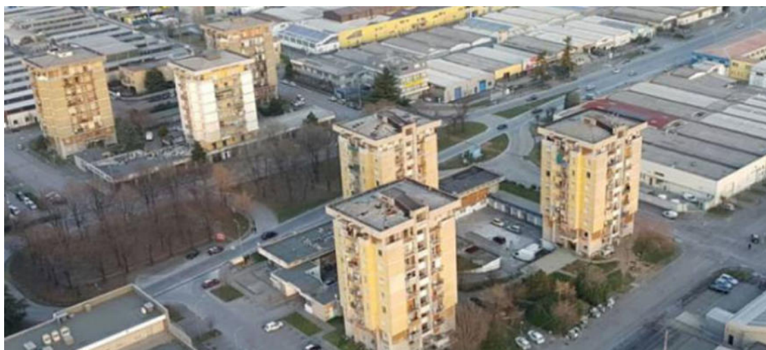
Le sei torri di Ciserano prima dell'abbattimento
