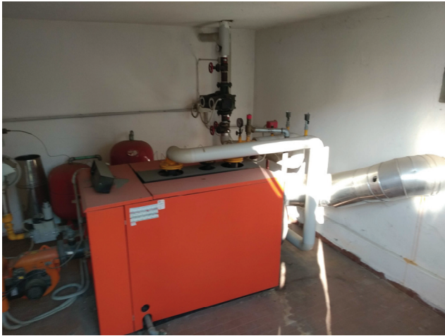
Figura 8 – generatore di calore
