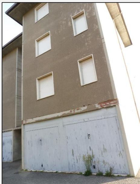
La trave in corrispondenza della soletta tra piano terra (box) e primo piano è in uno stato di forte degrado, ormai il cemento è quasi completamente sgretolato e per grosse porzioni affiorano i ferri d'armatura.
