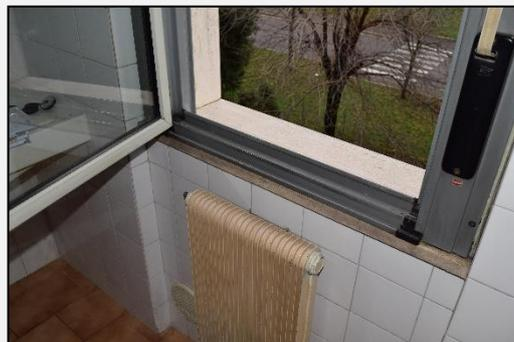
posizionata sulla battuta dell'anta, a formare un giunto chiuso. La  $U_w$  sarà  $\leq 1,4$  W/mqK. Il sistema sarà integrato con zanzariera con meccanismo a molla ad avvolgimento verticale realizzata in fibra di vetro e rivestita in PVC. Anche le attuali
