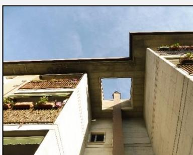
In questo caso la scelta progettuale è stata quella di utilizzare un rivestimento in EPS con successivo strato di protezione adatto ad essere utilizzato all'esterno. Anche il sottogronda sarà isolato con sistema a cappotto fissato sul cemento armato della gronda stessa, in modo tale da garantire all'intero edificio di essere trattato come una scatola e ridurre al minimo le dispersioni.
